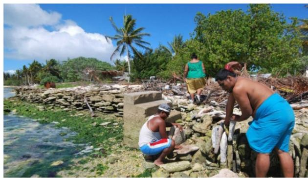
Construction de digue pour lutter contre la montée des eaux dans les îles coralliennes © C/C
